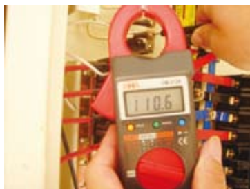
用鉤錶檢測電箱，兩側電壓差距不超過10%。
